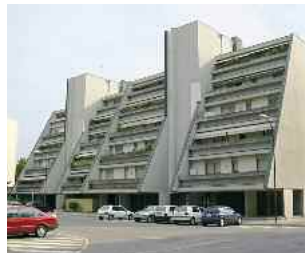
Nella foto: un fabbricato di Treviso, Piazza Donatori di Sangue, nella situazione attuale
