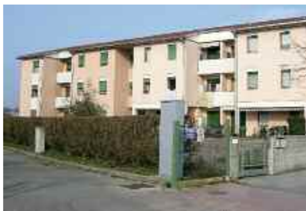
Nella foto: il fabbricato di Treviso, S. Bona Nuova, nella situazione attuale
